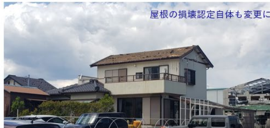
屋根が激しく損壊し、 屋根から雨水が侵入 (当初の被災直後の住家被害認定調査では雨水侵入の被害が十分に考慮されず)
