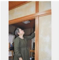
自宅2階で、地震で床から天井まで柱にひびが入ったままの柱を見る菅沢さん
