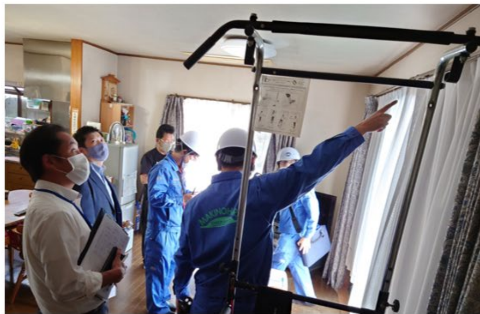
屋根から侵入した 雨水の痕跡を調査する税務課職員 (弁護士、工務店、災害NPOなども立会い、被害を説明)
