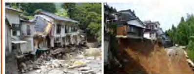
【平成29年台風18号等での基礎・地盤被害による住家被害の例】
